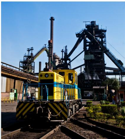
➤ O Alto-Forno transforma o minério e as pelotas em ferro gusa, nesta parte do processo, quando ocorre a lavagem de gases, é gerada a lama de Alto-Forno
